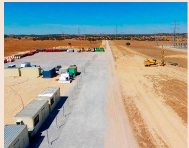
Una imagen de las obras en el concejo luso de Ouceijo.
